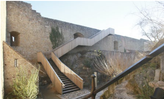
Escalier d'accès aux remparts Zugangstreppe zu den Mauern
